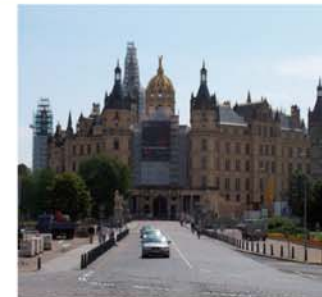
Sanierung/Spezialtiefbau Schloss Schwerin
